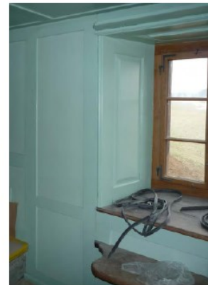
Gossau, Allenwinden, Innendämmung reduziert oben: nach Montage der Hilfskonstruktion unten: nach Remontage des Täfers (Abb. 62)
