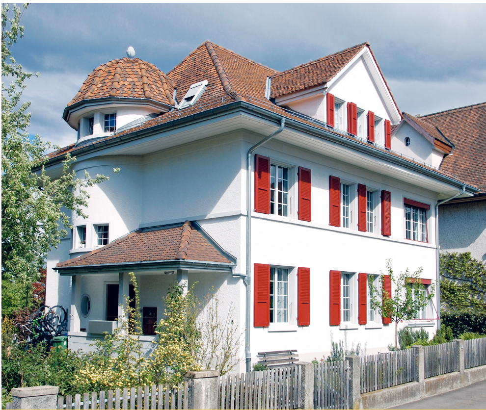
Ein Teil der Arbeiten konnte von der Strasse aus erfolgen. Das minimierte die Eingriffe auf dem Grundstück. Bild: B. Guggisberg
